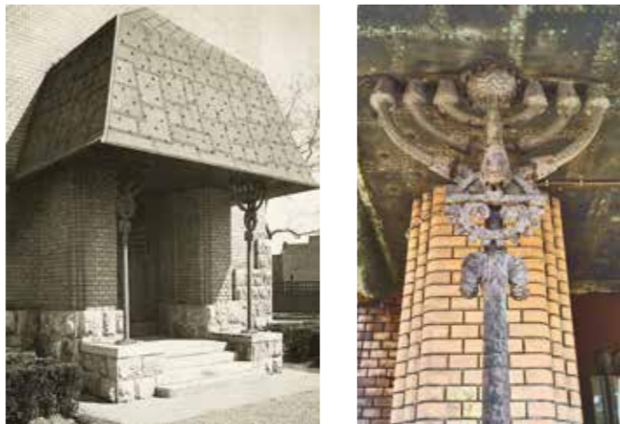
A tornatermi bejárat rézlemez borítású előtetője (Anton Schroll: Budapest új épületei . II.) és az előtetőt tartó menóra-oszlop (Klein Rudolf felvétele)
