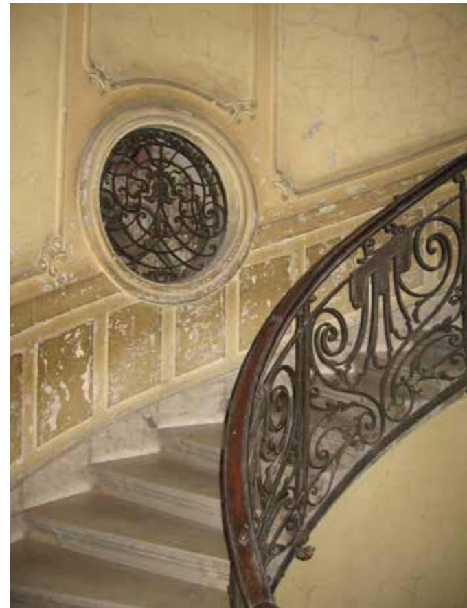
A RIMAMURÁNY–SALGÓTARJÁNI VASMŰ RT. NYUGDÍJINTÉZETI BÉRHÁZA (BUDAPEST, V., NÁDOR U. 36.)
